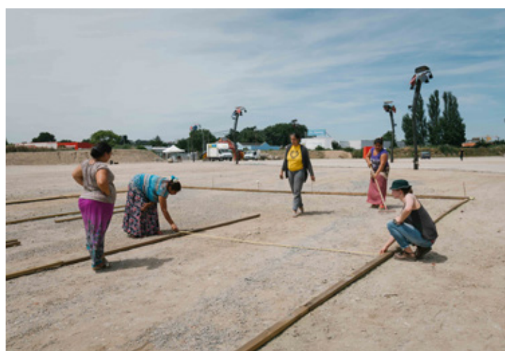
Chantier terrains de pétanque © Jérémie Jéhanin
